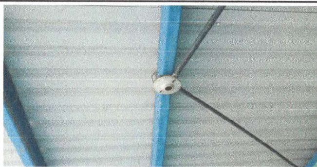
Foto 5: Sustrucion de plafoneras
