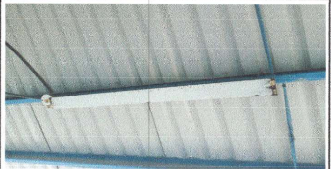
Foto 4: Sustrucion de focos ahorradores
