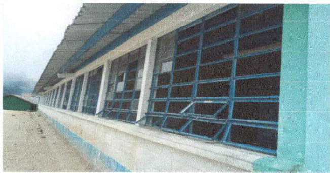
Foto1: Sustrucion de Vidrios
