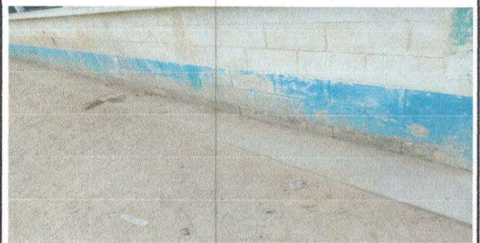
Foto 2: Pintura en muros exteriores e interiores
